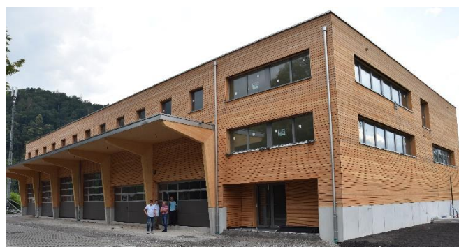
Der neue Werkhof wird vom Elektrizitätswerk der Stadt Buchs und vom Forstbetrieb Grabus genutzt. Bild: zvg
