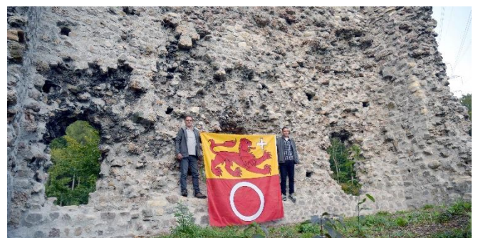
Die Puffermauer der Burgruine Niederwindegg wurde gesäubert, stabilisiert und befestigt. Bild: zvg
