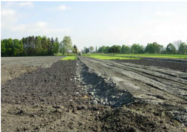
Das Material wurden mit einem Raupenbagger verteilt. Pro Piste waren ca. 1.5 Tage notwendig.
