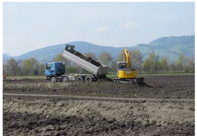
Aushubmaterial wird mit Lastwagen angeliefert und mit einem kleinen Raupenbagger verteilt.
