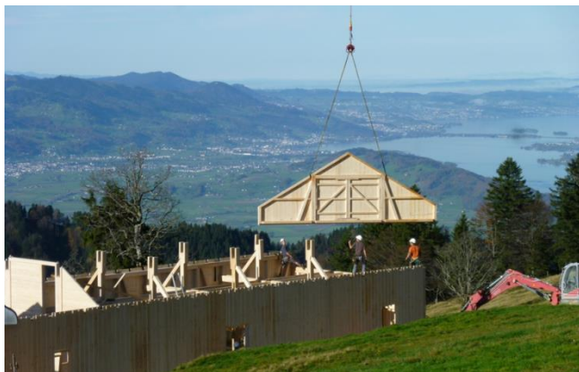
Alpgebäude in der Bauphase
